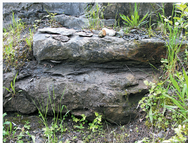
Fig. 15. Vue de détail du front d'exploitation de la carrière abandonnée de La Roquette, à environ 7 km à l'est de Tournai. Photo reproduite avec l'autorisation du propriétaire des lieux (SA Sagrex – site des Carrières Lemay) (© KIK-IRPA).
