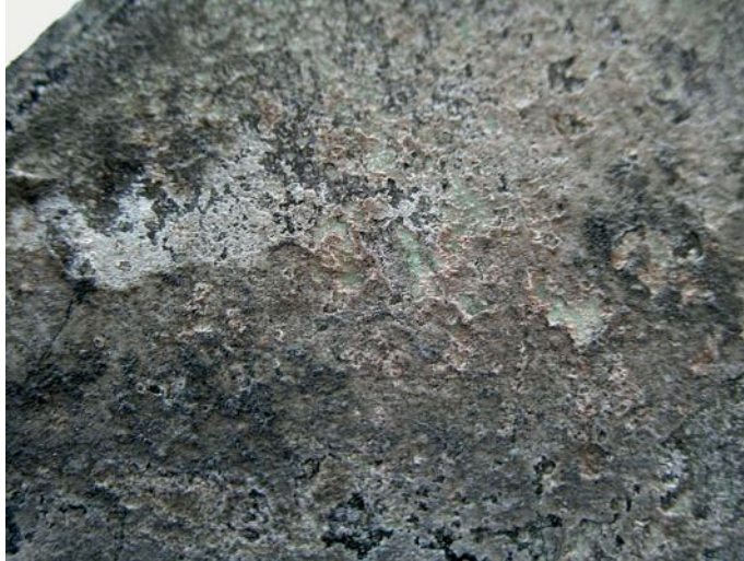
128a. Fragment 2 de la vitrierie de l'oculus 30 montrant une corrosion en croûte. Fragment 2 uit het glas-in-loodpaneel van oculus 30 die de korstcorrosie toont.
