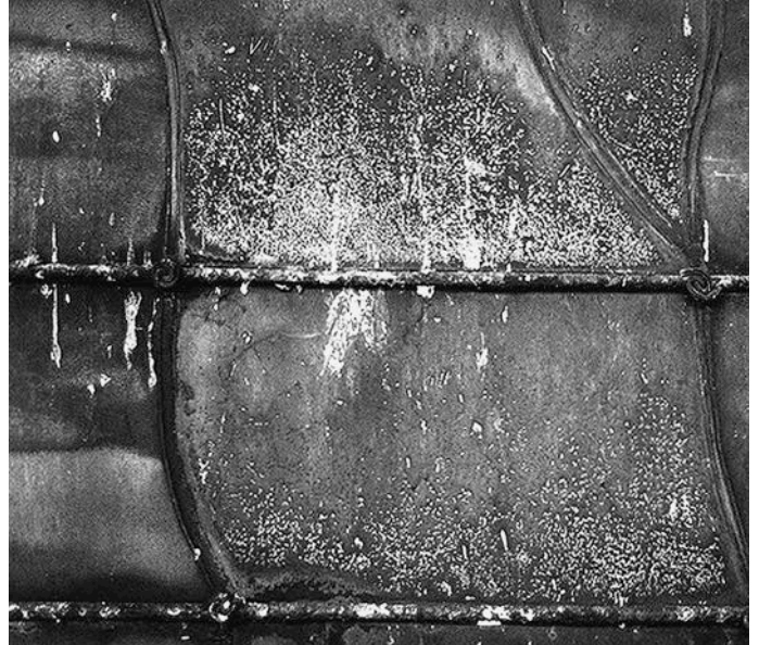
215. Présence locale de corrosion en cratères. Plaatselijke aanwezigheid van putcorrosie.
