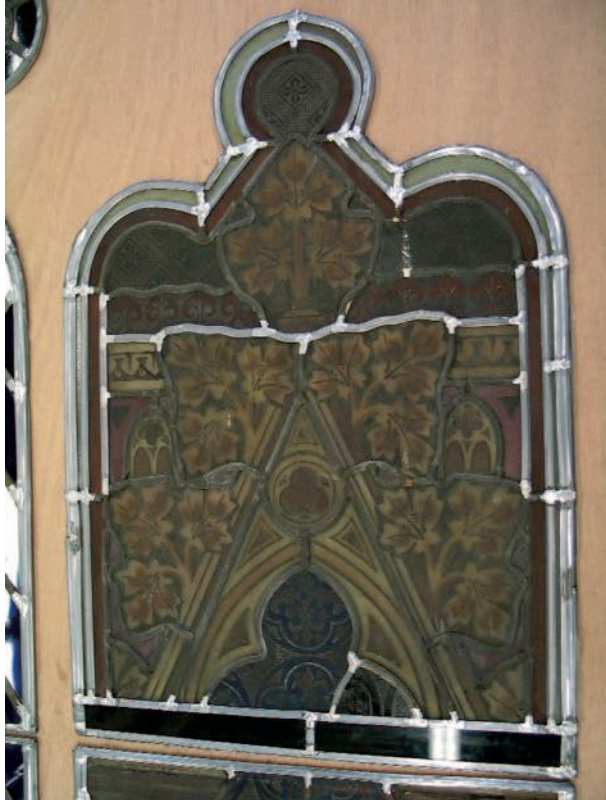
30. Geel, Renotec. Remise en plomb partielle. Geel, Renotec. Gedeeltelijke loodzetting.
