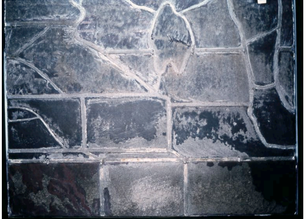
241. Fenêtre du transept SXII – panneau 1b. Croûte de crasse du côté extérieur. Kruisbeukraam ZXII – paneel 1b. Vuilkorsten buitenzijde.
