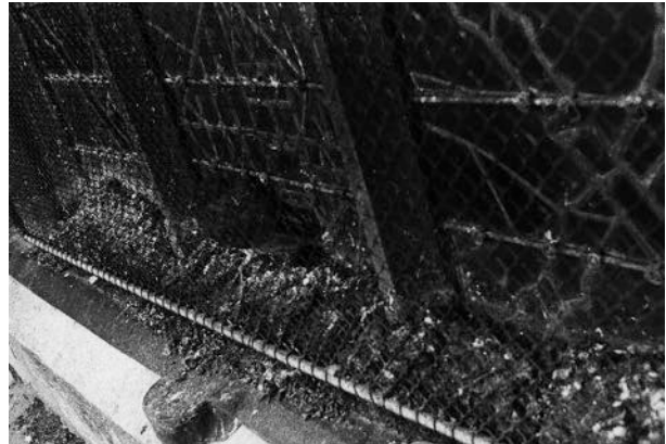
144. Grillage favorisant l'accumulation de saletés. Rooster dat de ophoping van vuil bevordert.
