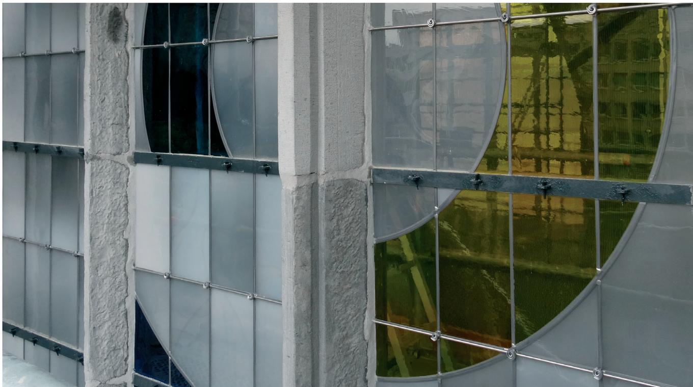
fig. 21 Armature d'un vitrail (feuillards, pannetons, clavettes et vergettes). © Isabelle Lecocq.
