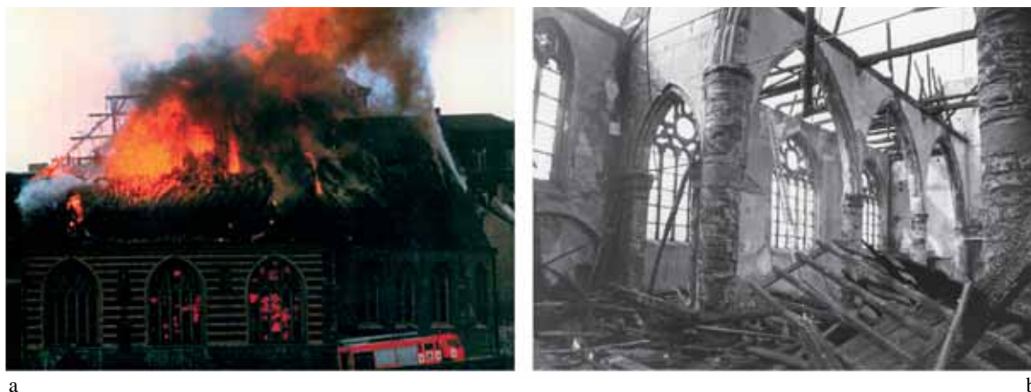
Fig. 2 : Incendie de l'église Saint-Servais, le 21 août 1981 (a), et intérieur de l'église dévastée (b) (© Fabrique d'église Saint-Servais [a] et © IRPA-KIK, Bruxelles [cliché 1981] [b]).
