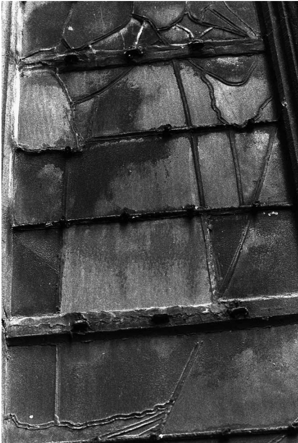
143. Observer la corrosion des vergettes, des feuillards et l'absence de clavette. Bemerk de corrosie van de bindroeden, van de losse bruggen en het ontbreken van de deugel.
