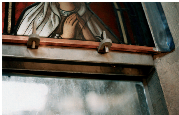
145. Dispositif adopté pour le placement du vitrage de protection. Opstelling voor het plaatsen van een beschermbeglazing.
