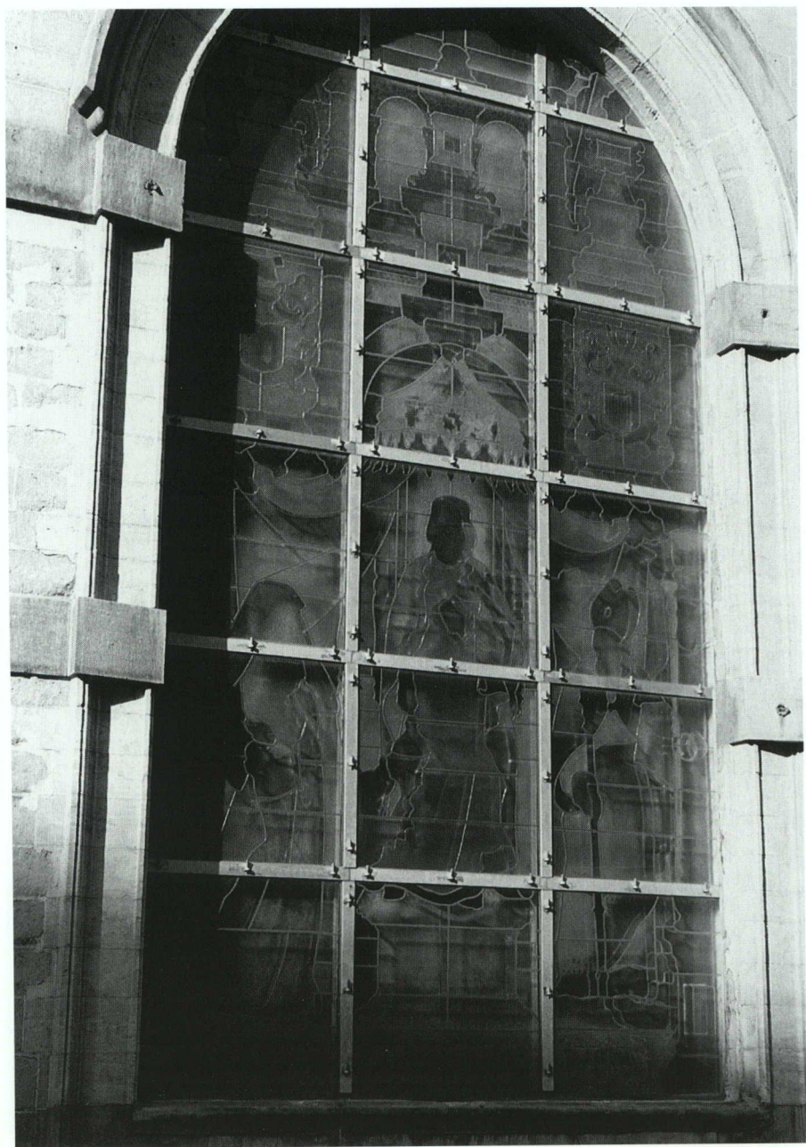
Fig. 11. Bruxelles, cathédrale des Saints-Michel-et-Gudule. Fenêtre de la chapelle Maes (cliché de l'auteur). Vitre de protection placée devant le vitrail représentant sainte Gudule (1843). La surface du verre est thermoformée et reproduit l'aspect du vitrail.
