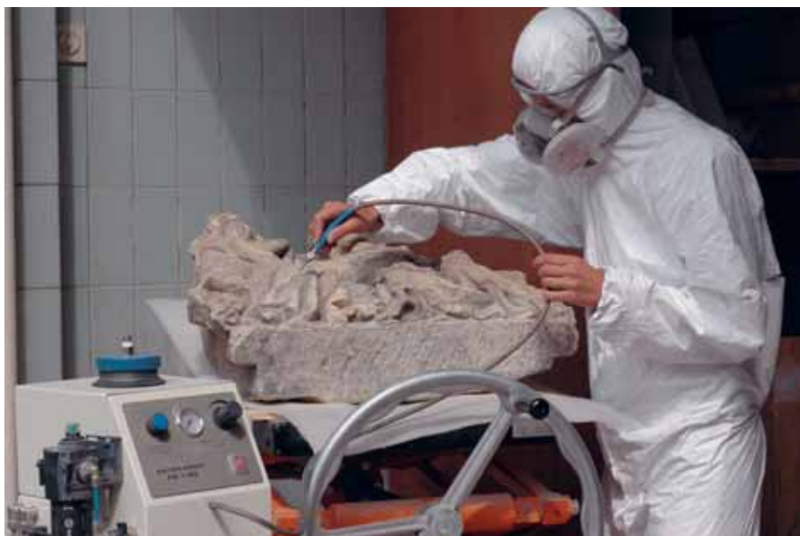
Afb. 15 Microzandstraling van het reliëf. 00029014-8.
