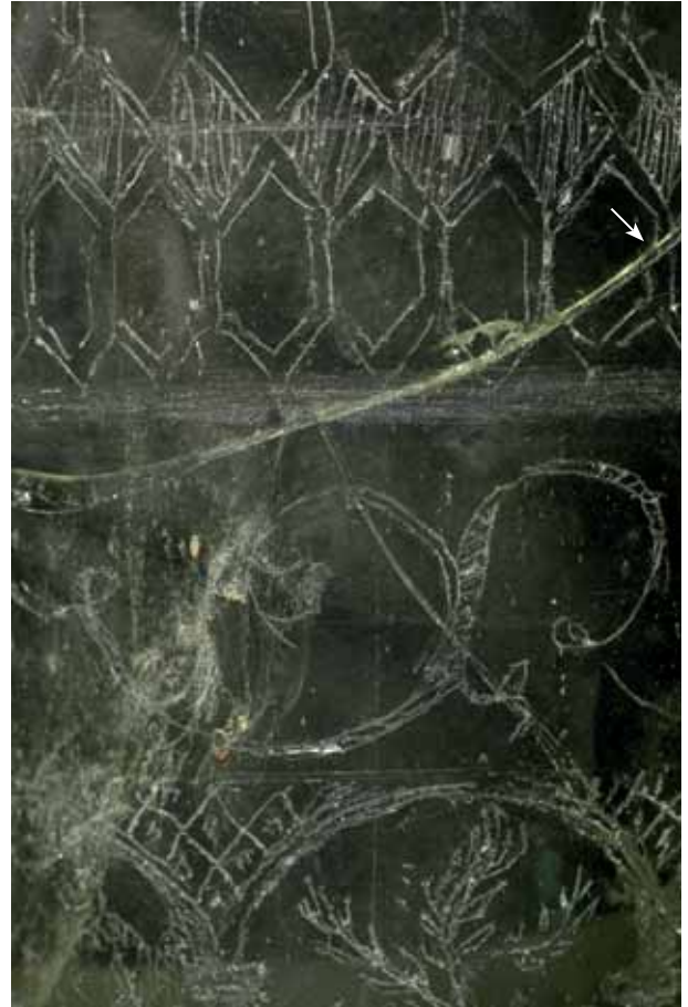
Fig. 12 Idem , détail. Dans la zone cernée, on aperçoit un décalage dans le raccord du trait de gravure, de part et d'autre d'un joint de collage. Voir flèche. LZ013128.
