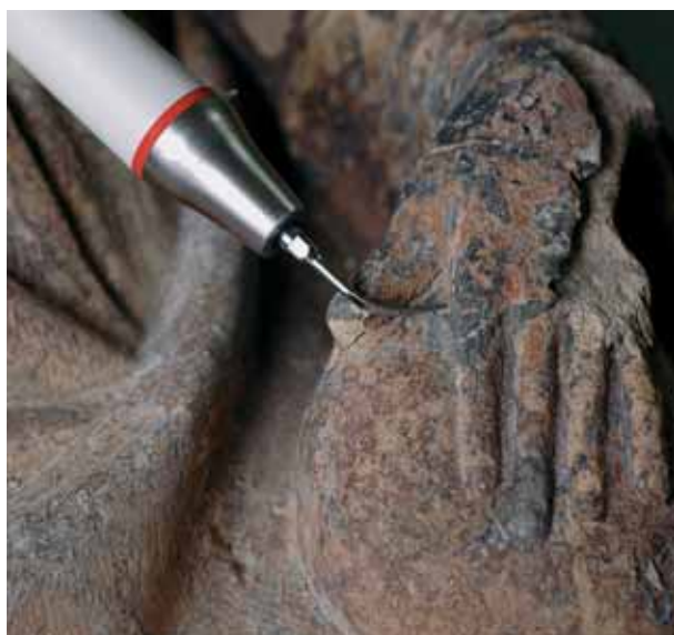
Afb. 16 Met een ultrasoon scaler wordt door middel van hoogfrequente trillingen de gipskorst verwijderd. 00029014-282.
