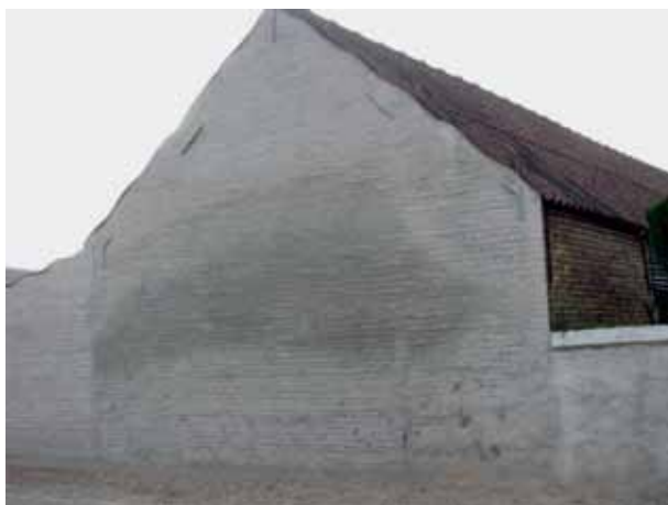
Afb.2 Gevel van een stal gecontamineerd met hygroscopische zouten. 70000012-0.
