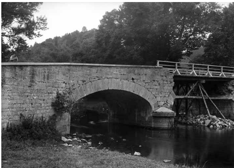
Fig. 7 Resteigne, pont à arches du XVIII e siècle, partiellement détruit pendant la Seconde Guerre. Photo Clément Dessart, 1945. A88483.
