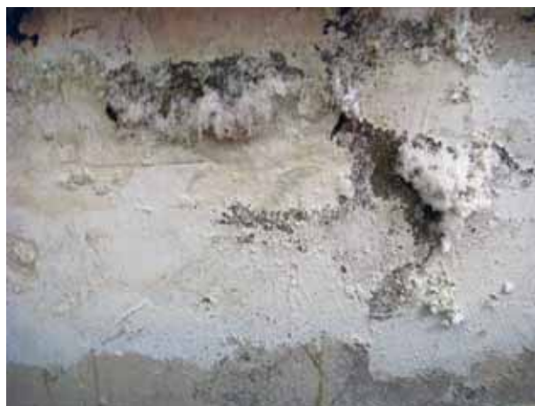
Afb.6 Zoutuitbloei bestaande uit tenardiet (Na 2 SO 4 ), natriumchloride (NaCl), kaliumnitraat (KNO 3 ), darapskiet (Na 3 NO 3 SO 4 ·H 2 O) en aftitaliet (K 3 Na(SO 4 ) 2 ) (XRD). 00008678-0.
