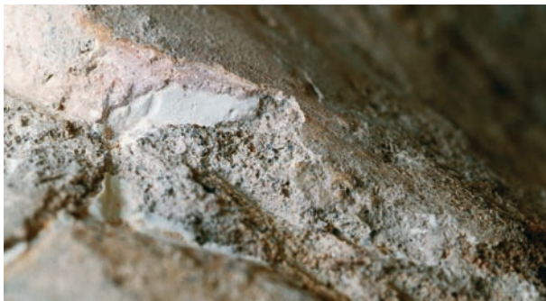
20 Superposition de produits de bouchage et de masticage. Opeenstapeling van producten voor het opvullen en het mastikeren.
