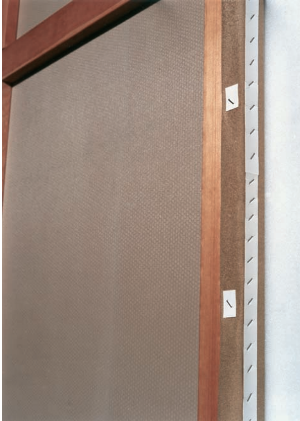
10 Le revers : détail du montage : nids d'abeilles, châssis, toile acrylique. Achterzijde, detail van de montage: honingraat, chassis, acryldoek.
