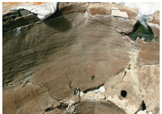
12 Intérieur, traces de travail aux doigts (soudure des colombins et lissage). Binnenzijde, sporen van het werken met de vingers (aanhechten van de colombins en gladstrijken).
