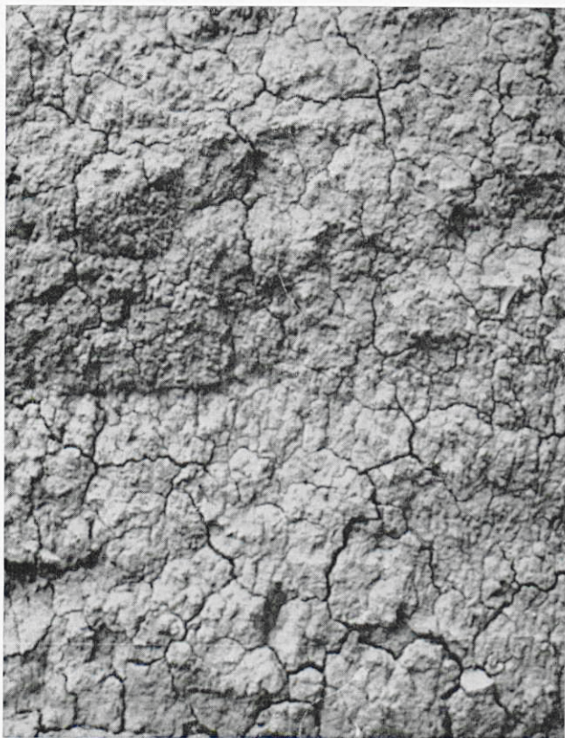
2. Niet-behandelde muur na twee jaar blootstelling aan de weersgesteldheid.
