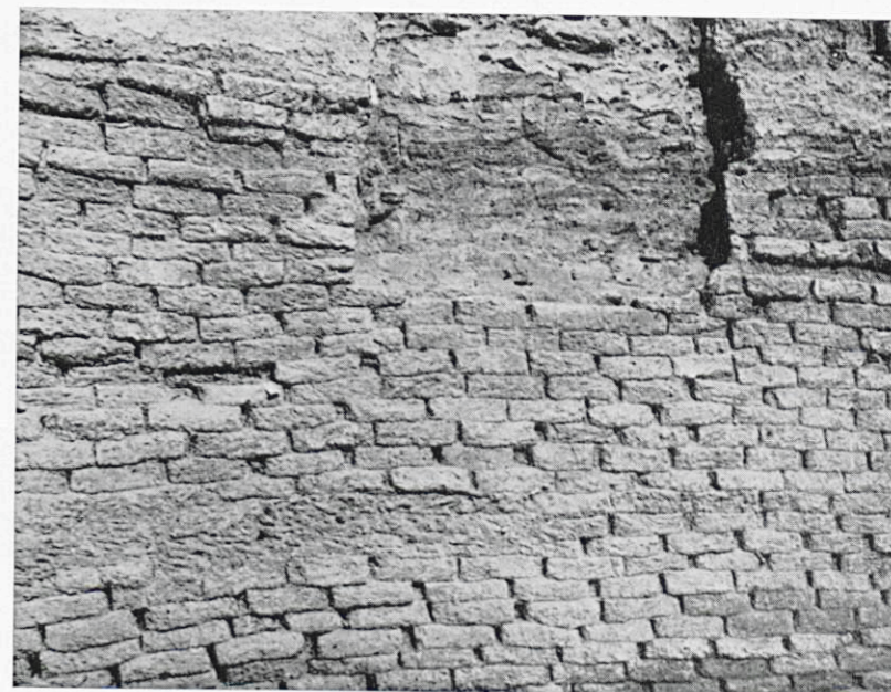
1. Muur onmiddellijk na blootlegging. Drie jaar na behandeling was een gelijkaardige muur nog in eenzelfde staat.
