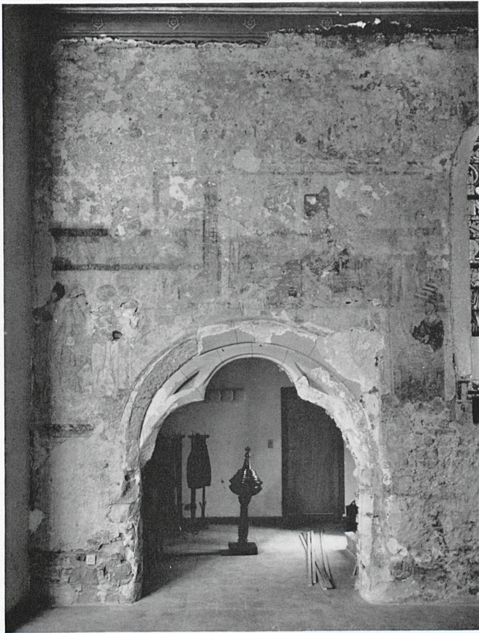
4. La paroi nord en cours de décapage, avant l'élimination des restes de surpeints.
