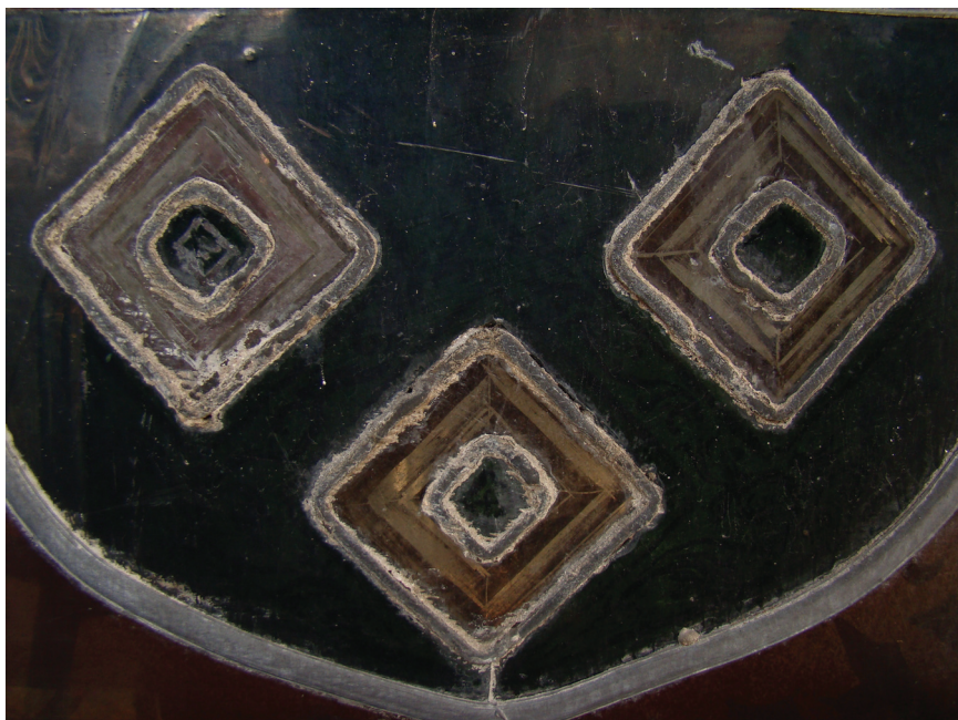
Fig. 29 : Trois « chefs-d'œuvre » insérés dans trois pièces elles-mêmes insérées en « chefs-d'œuvre » dans une pièce de verre des armoiries Boutersem. Liège, Église Saint-Jacques, vitrail d'Éverard de La Marck, ca. 1525. Photo I. Lecocq.
