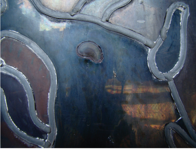
Fig. 30 : Pièce insérée en chef-d'œuvre sans le recours à un plomb de maintien. Liège, Église Saint-Jacques, vitrail de Marguerite de Hornes, ca. 1525. Photo I. Lecocq.
