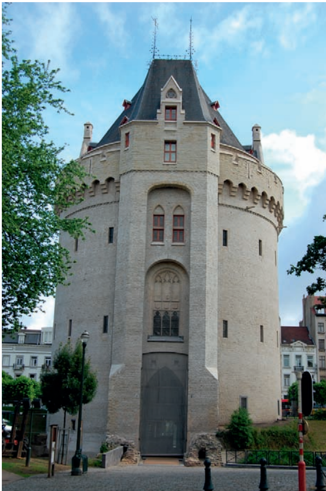
Fig. 2. Porte de Hal, vue de la tour depuis Saint-Gilles ( extra-muros ). Le parement extérieur est uniquement construit en pierre. La partie sommitale est le fruit de la restauration de Hendrik Beyaert durant le troisième quart du XIX e siècle (S. Modrie © DMS/SPRB)
