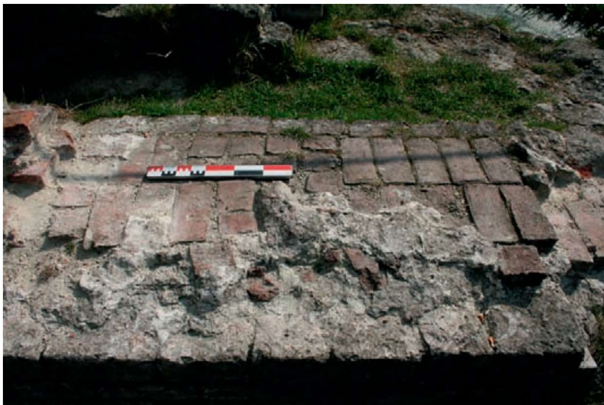
Fig. 3. Porte de Hal, Bruxelles/Saint-Gilles, parement intérieur au deuxième niveau de la tour (P. Sosnowska © CReA-Patrimoine/ULB)
