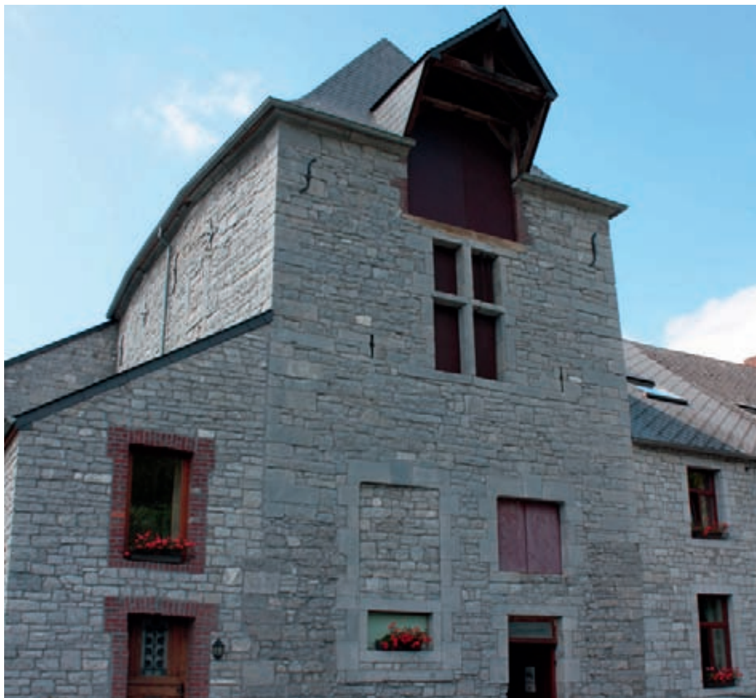
Fig. 1. Manoir de Lompret (commune de Chimay, ancien comté de Hainaut), XVI e -XVII e siècles. Vue de la façade à cour du corps de logis, formant. Cl. Mathieu, 2011.
