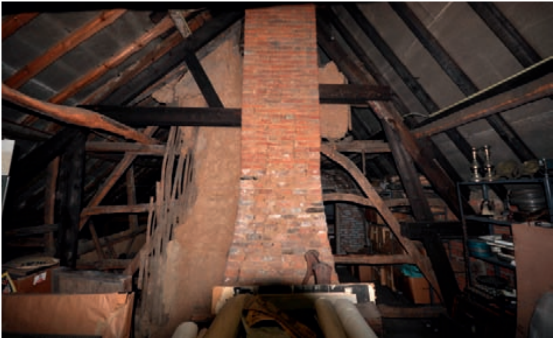
Fig. 8. Béguinage d'Anderlecht, cheminée centrale chauffant le rez-de-chaussée, état restauré mais comprenant des maçonneries datées du xv e siècle (P. Charruadas, P. Sosnowska © CReA-Patrimoine/ULB)
