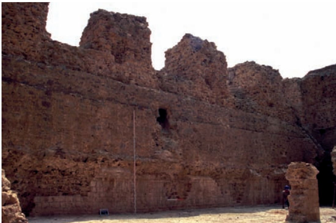
Fig. 4. Le mur gouttereau sud-est depuis les caves sous l'aula. (Photo : D. Dehon © SPW/DGO4)
