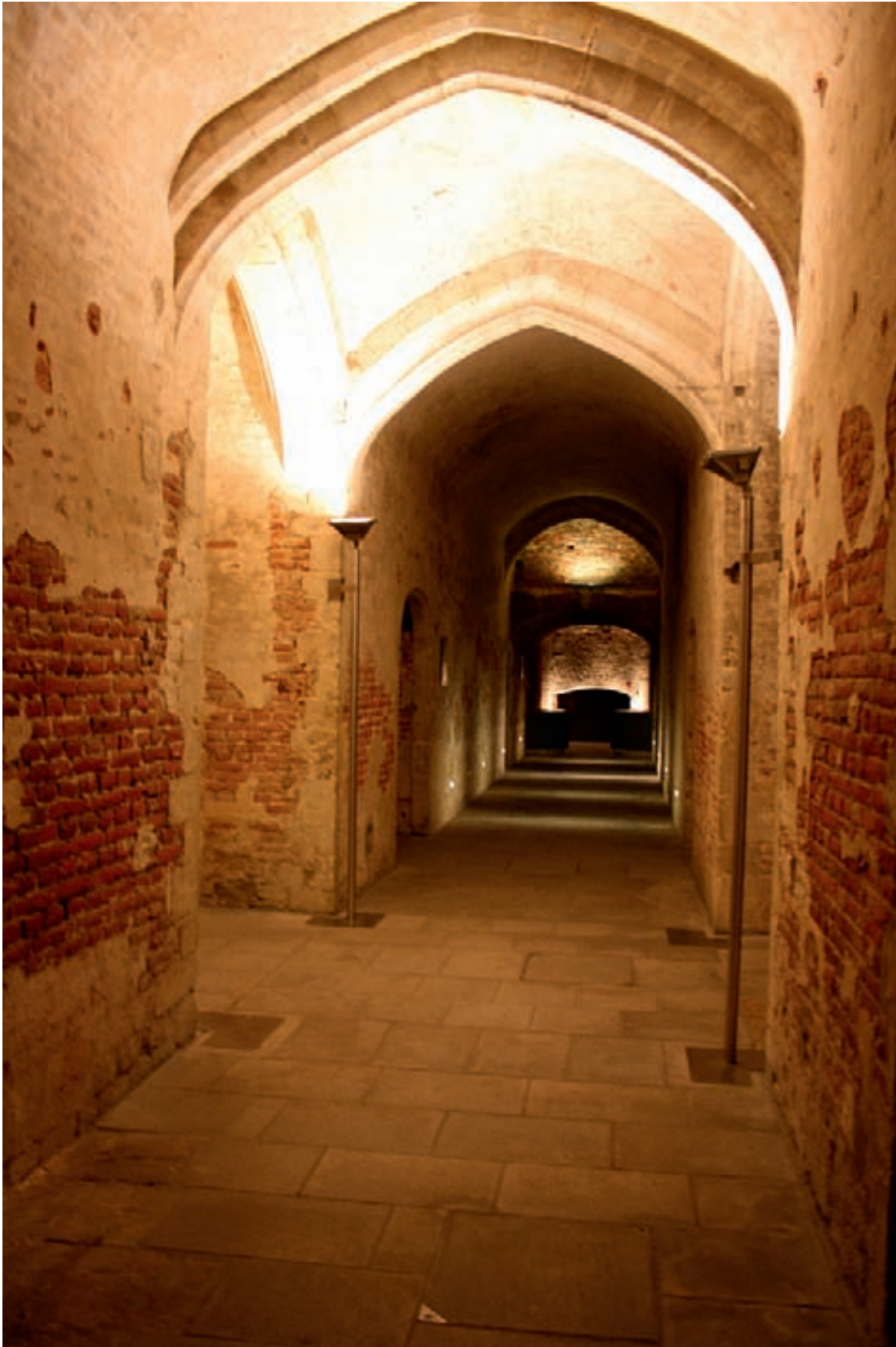
Fig. 9. Site du Palais du Coudenberg, Bruxelles, couloir intérieur du premier niveau de la chapelle impériale (P. Sosnowska © CReA-Patrimoine/ULB - DMS/SPRB - MRAH)
