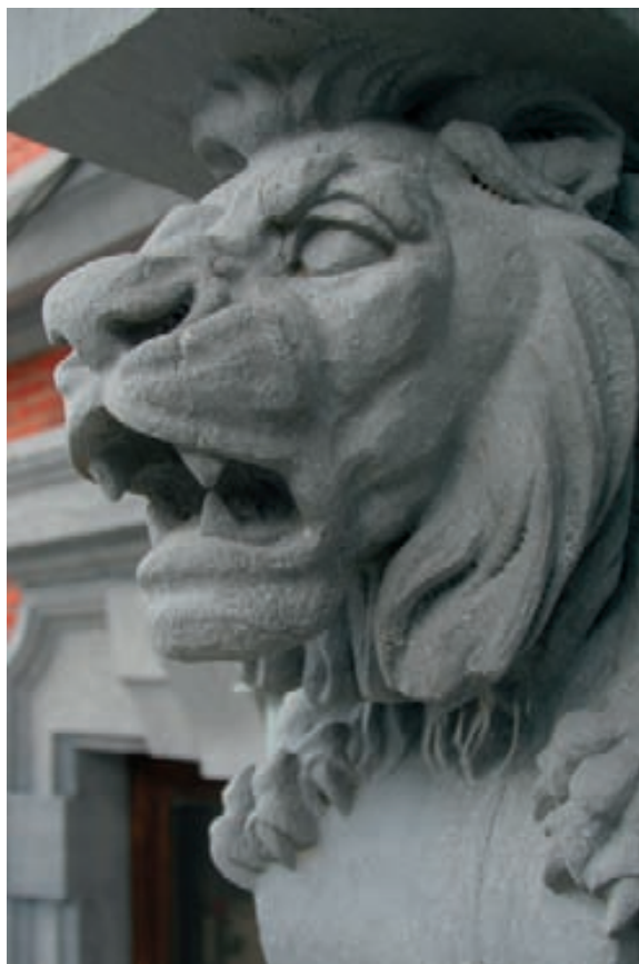
Une des deux consoles en forme de lion supportant la logette en façade à rue. Petit granit taillé. (© Vincent Heymans – Cellule Patrimoine Historique).
