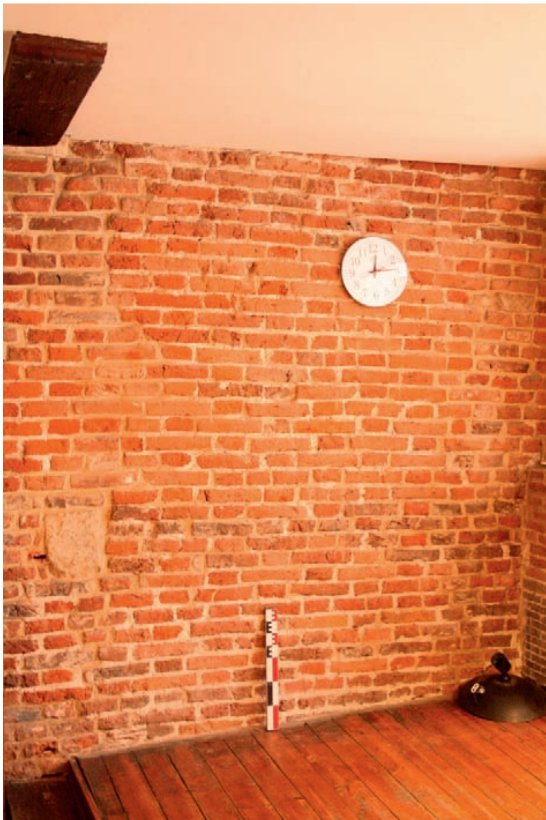
Fig. 10. Rue de Laeken 120, Bruxelles, mur gouttereau septentrional daté du XVI e siècle (P. Sosnowska © CReA-Patrimoine/ULB)
