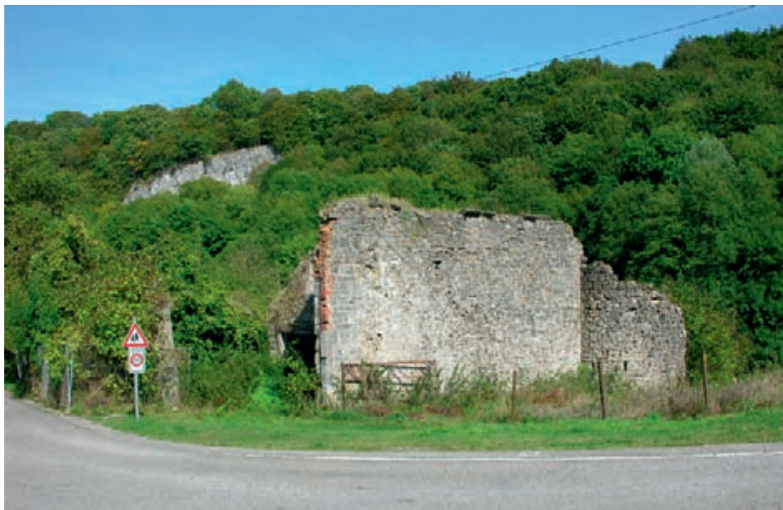
Fig. 2. Manoir de Lompret (commune de Chimay, ancien comté de Hainaut). Vue de l'ancienne tour d'angle en ruine. Cl. Mathieu, 2011.
