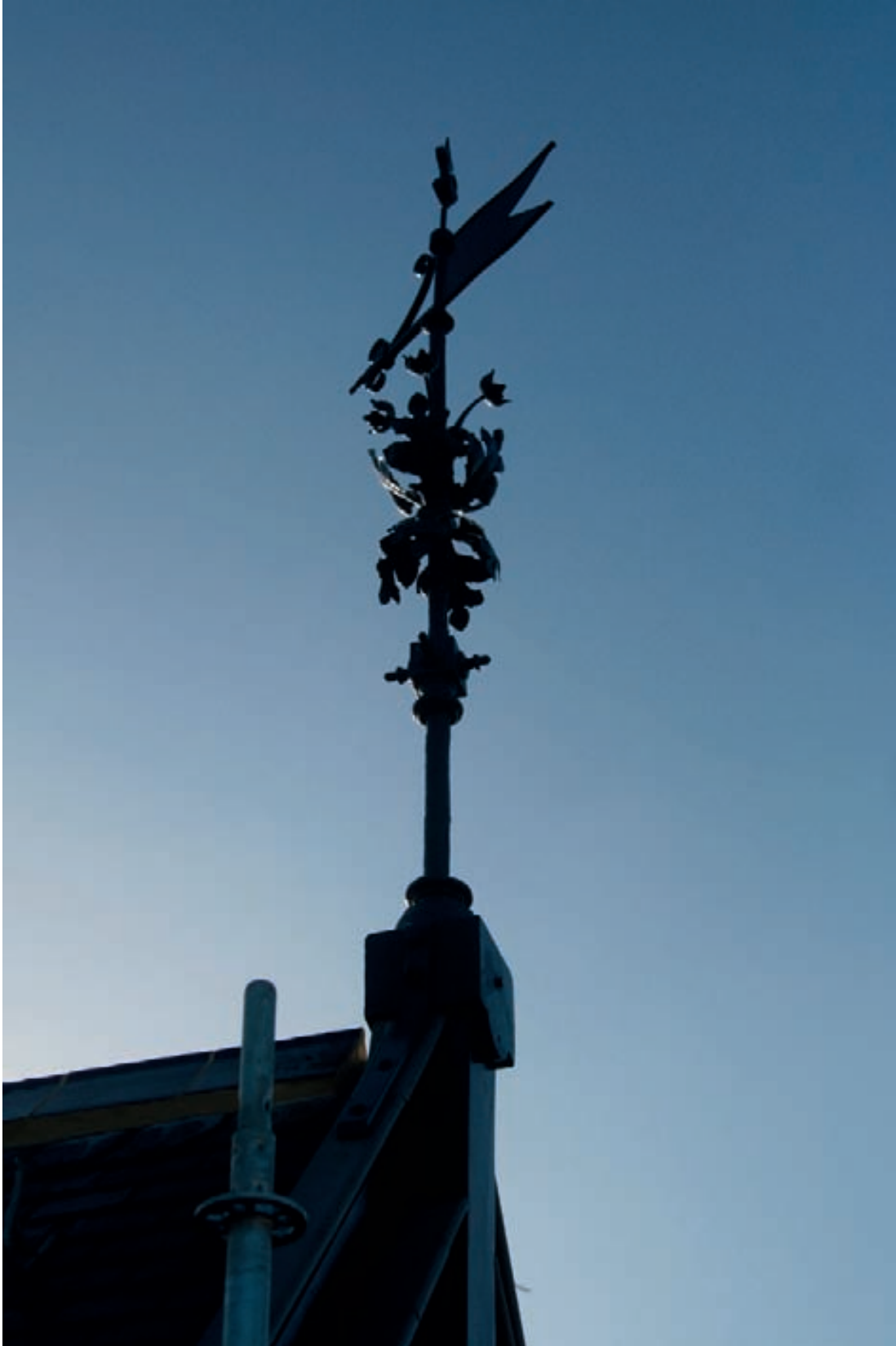
Girouette replacée au faite du pignon, le 13 novembre 2013. Fer forgé et martelé. (© Vincent Heymans – Cellule Patrimoine Historique).
