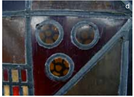
Fig. 23.- Pièces de verre insérées en chef-d'œuvre : a et d) vitrail de Marguerite de Hornes (SIII), panneaux 5b et 10b ; b) vitrail des Trente-deux Bons Métiers (NIII), panneau 14c ; c) vitrail d'Éverard de La Marck (SII), panneau 17b. © Isabelle Lecocq.
