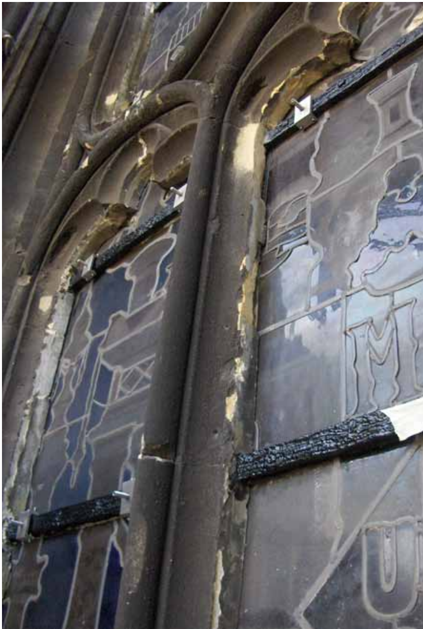
Fig. 33.- Traitement anti rouille des barlotières et pose des cavaliers. © Architectes associés s.a., société civile d'architectes.
