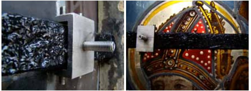
Fig. 36.- Pose d'un cavalier sur une barlotière avant la mise en place des verres de protection. © Isabelle Lecocq.
