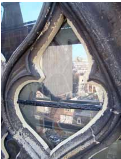
Fig. 39.- Réalisation du calfeutrement au mortier de chaux dans les jours de réseau. Les ouvertures haute et basse destinées à la ventilation sont visibles. © Isabelle Lecocq.
