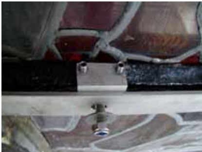
Fig. 37.- Mise en place d'un feuillard. © Isabelle Lecocq.
