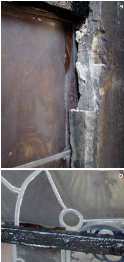
Fig. 20.- Protection du verre : a) par le calfeutrement : vitrail de Marguerite de Hornes (SIII), panneau 3a ; b) par les barlotières : vitrail de Marguerite de Hornes (SIII), panneaux 3b. © Isabelle Lecocq.
