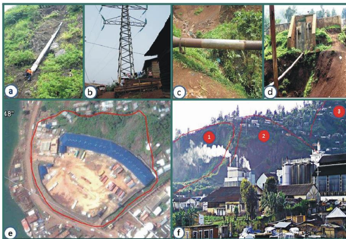
Figure 9. Quelques infrastructures exposées aux glissements de terrain.
