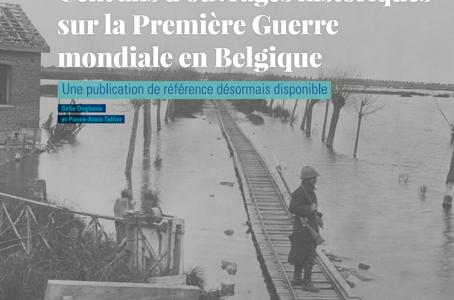
L'inondation en Flandre, passerelle sur pilotis, 1914. AGR-AR, P-IconoWW1, 1627. © AGR-AR
