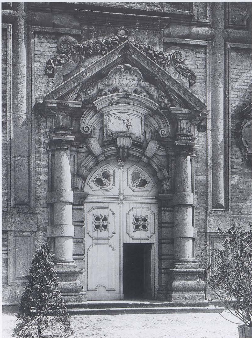
109. Jan II van den Eynde. Portiektravee, toegang tot de kerk (B70271).
