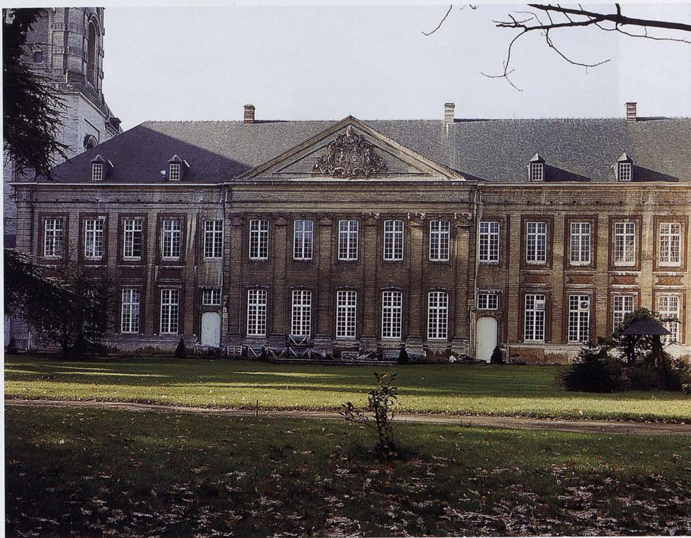
Pl. 7. Kloostergebouw, oostvleugel, 1739-1744. Extérieur, gezicht vanuit de abdijtuin (KN5832, 1996).
