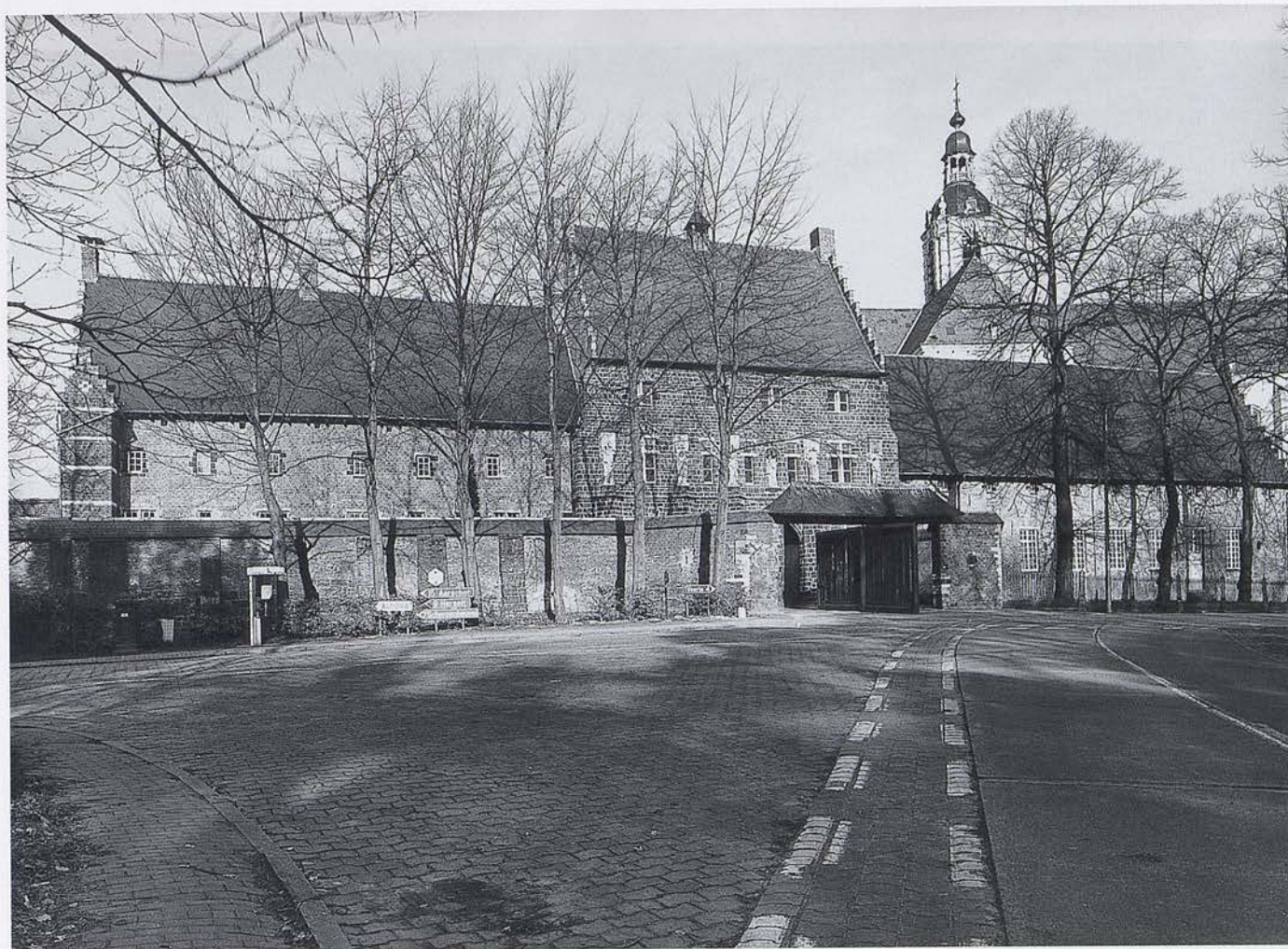
Pl. 3. Poortgebouw, 1368-1394, met toegangspoort. Extérieur, zuidzijde met aanleunende gebouwen (N13212, 1990).
