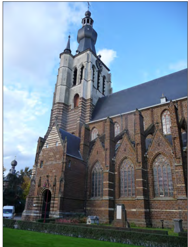
Figuur 5. Een zeer kenmerkend voorbeeld van de lokale architectuur in de Demerstreek is de Onze-Lieve-Vrouwekerk te Aarschot. IJzerzandsteen werd hier in het gevelparement gebruikt in combinatie met witstenen speklagen in Gobertangestein.
