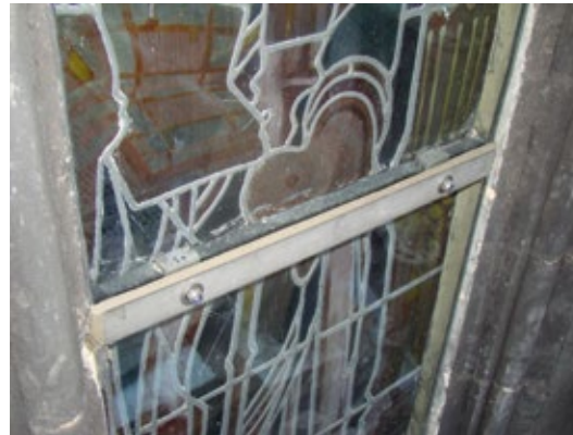
Fig. 166. Vitrage de protection en place.
