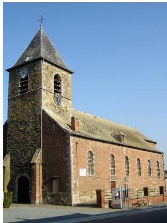
Eglise Saint-Sauveur, Place de Petit-Enghien
