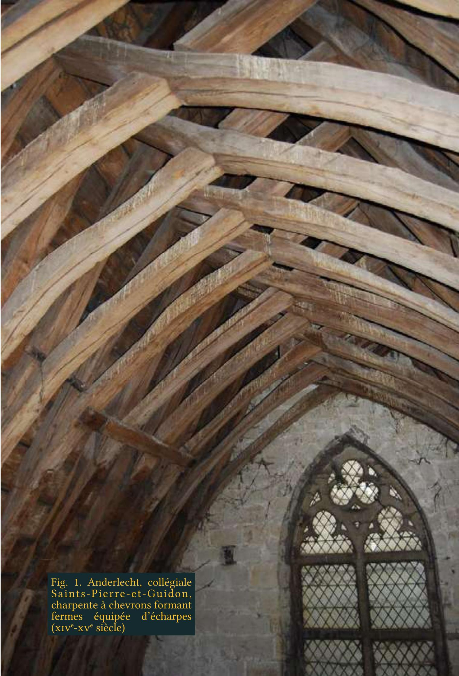
Fig. 1. Anderlecht, collégiale Saints-Pierre-et-Guidon, charpente à chevrons formant fermes équipée d'écharpes (xiv<sup>e</sup>-xv<sup>e</sup> siècle)
