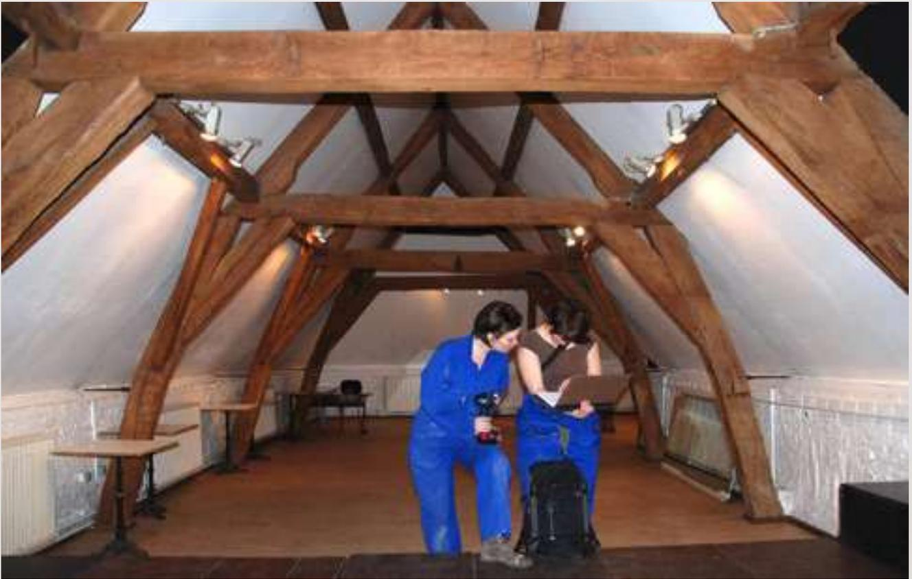
Fig. 5. La charpente à fermes et pannes, et chevalets, adaptée au comble aménagé, avec le plancher abaissé grâce au mur bahut (comble à surcroît). Sylvianne Modrie et Armelle Weitz étudient la charpente d'une des ailes de la Ferme Rose à Uccle.
