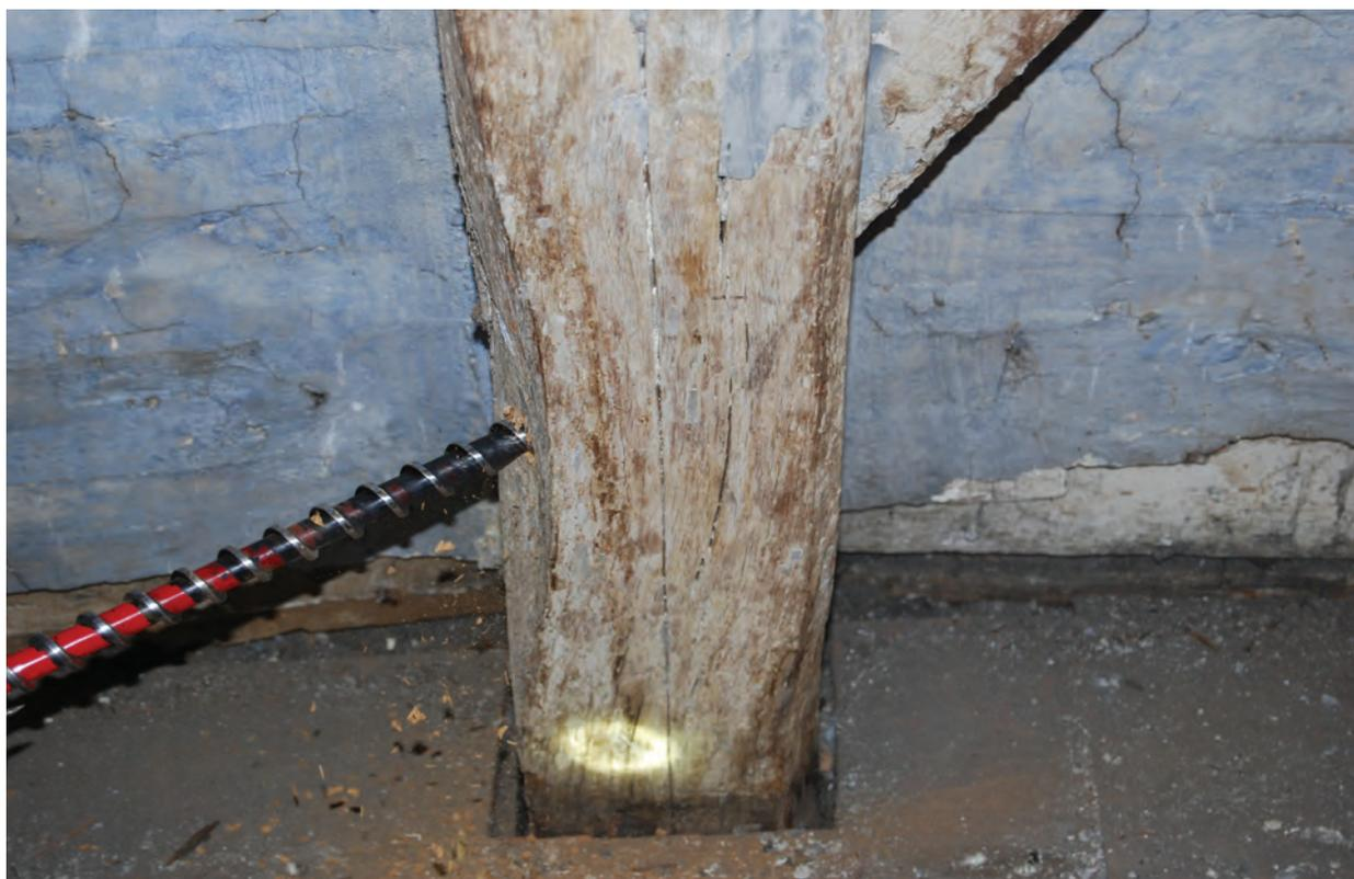
Fig. 2. Prélèvement à la tarière dans la zone de flèche, sans cambium ou écorce visibles - Charpente de l'église Notre-Dame du Sablon, Bruxelles. © auteur : A. Weitz, photo de travail IRPA, 2015, urban.brussels.
