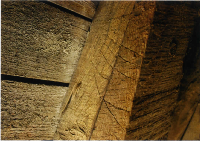
Fig. 2 : Détail d'une marque d'assemblage sur le chevron et le potelet d'une ferme secondaire du transept nord marquée « 8 » avec une marque de latéralisation (photo : S. Crémer © SRPB).
