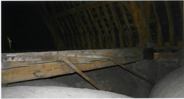
Fig. 3 : Tirants métalliques liaisonnant les entrails aux murs gouttereaux et arcs doubleaux en briques, placés dès la construction de la nef (partie est) de l'église Notre-Dame du Sablon, fin xv e siècle (photo : C. Maggi © SRPB).
