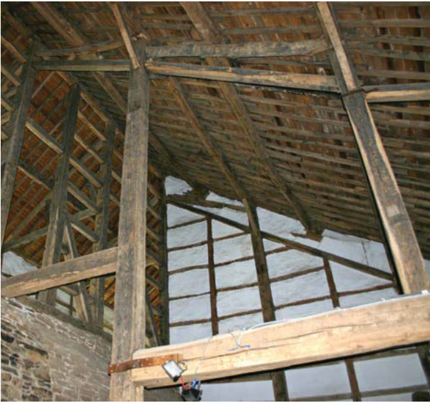
Fig. 32. Halle à charbon, Fourneaux Saint-Michel, Saint-Hubert. Photo: Labo Dendro IRPA, photo de travail, 2015 © IRPA, Bruxelles
