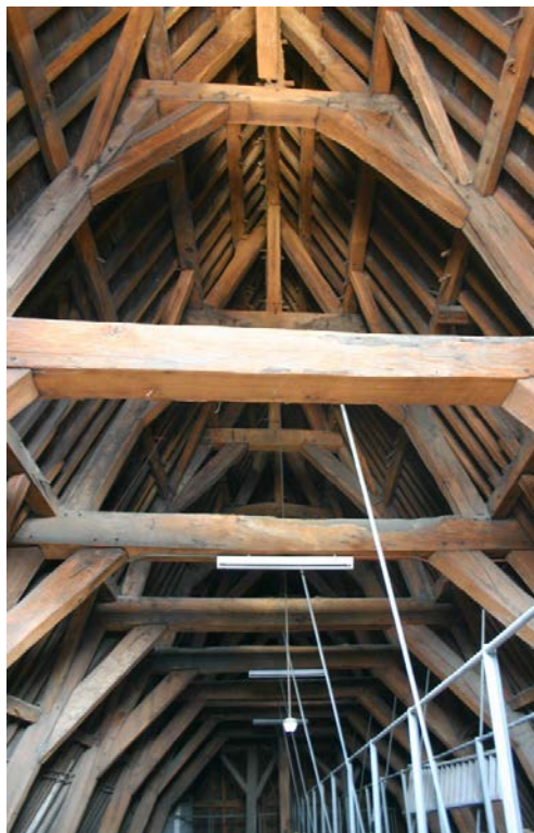
Fig. 1 – Vue générale des portiques supérieurs de la charpente de l'aile orientale – Rue Charles Buls (1.2) (Photo de travail ULiège/IRPA 2018 © SPRB).
