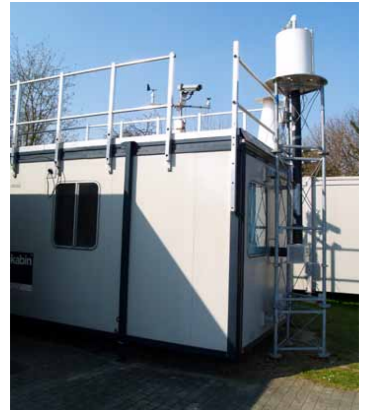
Plateforme d'observation avec suiveurs solaires
