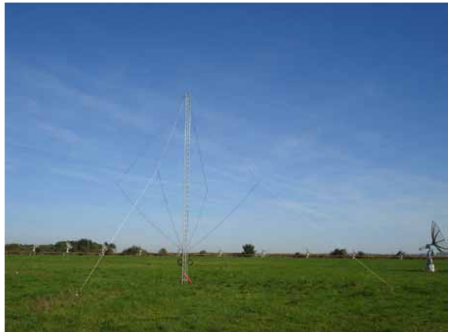
Figuur 3. De VLF antenne in Humain, met een 12 meter hoge mast.
