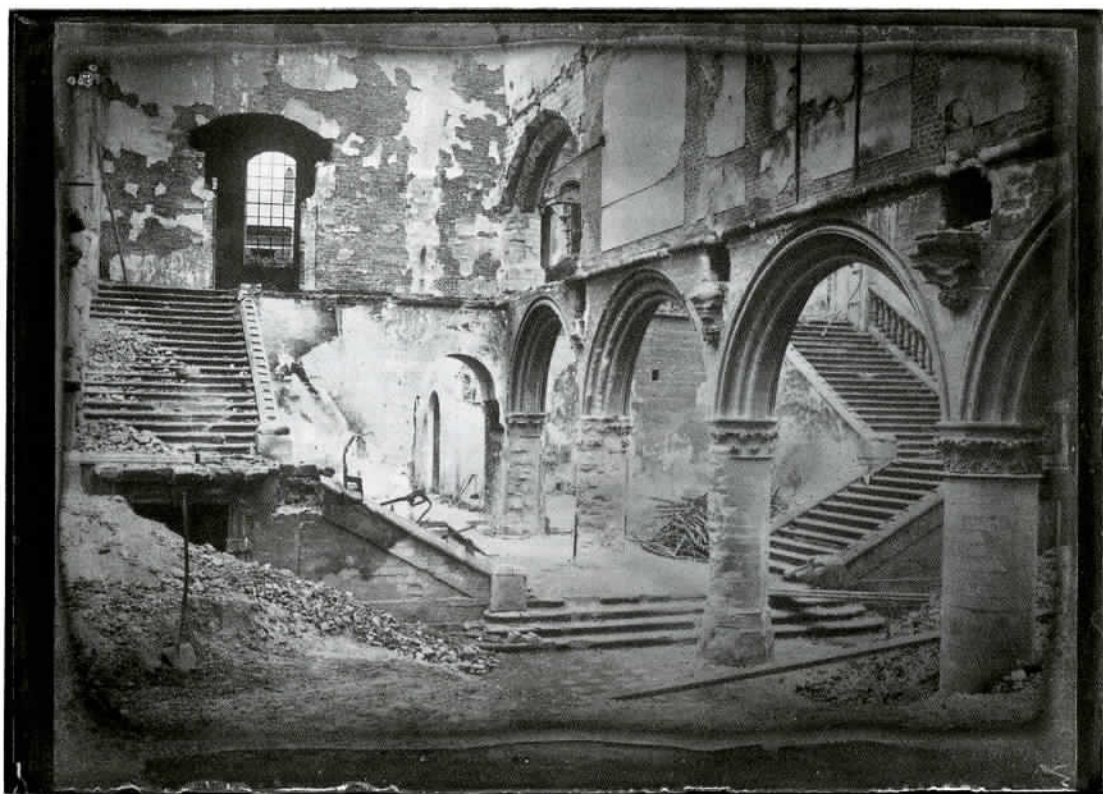
Vue intérieure de la Bibliothèque universitaire de Louvain après son incendie par les Allemands en 1914 [extraite du recueil Louvain en ruines ]. Photographes : Pierre Alphonse et Pierre Emile Arnou - R-2009-17004
