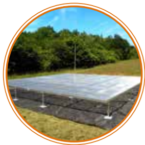
Een meteorenradar in aanbouw in Dourbes
