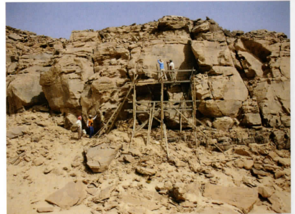
De hauts échafaudages en bois sont fabriqués pour pouvoir atteindre les panneaux d'art rupestre. Hoge houten stellingen moesten worden opgetrokken om de rotstekeningen te kunnen bereiken.
