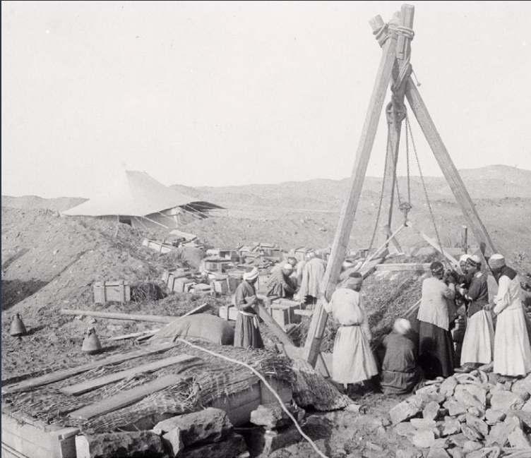
← Afb. 14 Het ontmantelen van de mastaba van Neferirtenef te Sakkara. De onderdelen worden ingepakt in houten kratten, die ter plaatse op maat gemaakt werden. Foto genomen door de Britse egyptoloog James Quibell, 1906. © KMKG-MRAH, EGI 93.
